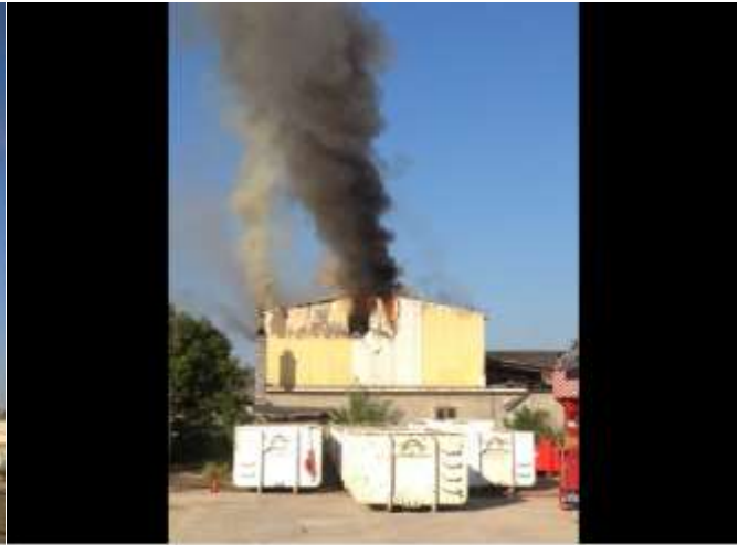
2/6 Die rasch angerückte Feuerwehr fand den Schuppen bereits im Vollbrand vor.
